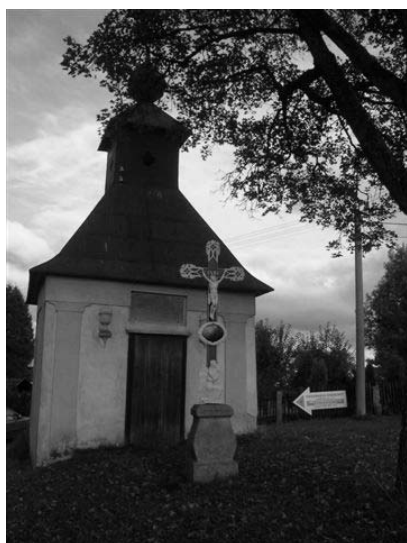
kaplička před opravou
