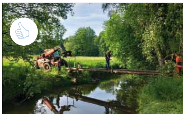
11.6. Členové záchranné jednotky Jarošov nad Nežárkou za pomoci techniky ZD Rodvínov obnovili lávku přes řeku Kameničku u střelnice AVZO. ☺
