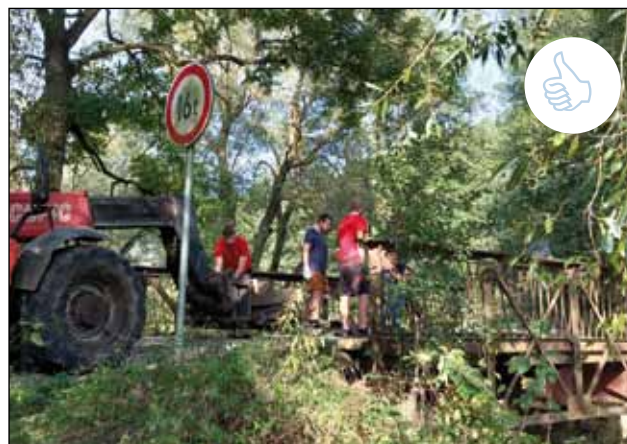
18. 9. Děkujeme mužům z Hostějve a Pejdlvy Rosičky za opravu mostu přes řeku Žirovničku. ☺
